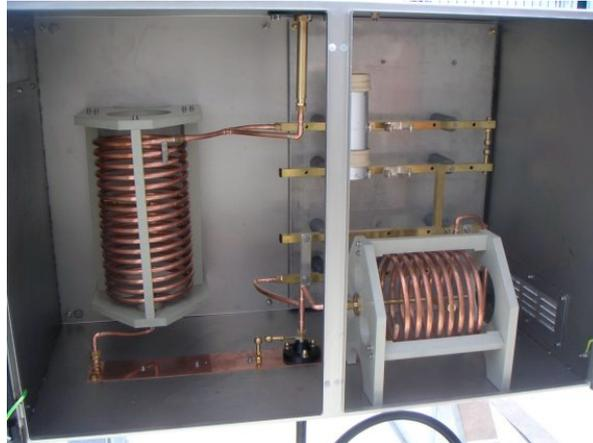
Pour cela, nous utiliserons une cellule en pi dont le principal intérêt est d'assurer l'écoulement des charges via une self placée en parallèle entre l'antenne et la masse et une autre entre l'émetteur et la masse.
